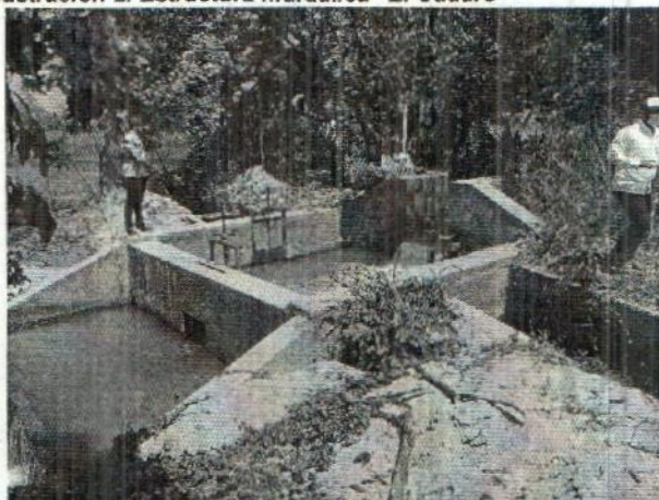
Ilustración 2. Estructura hidráulica "El Cuadro"
